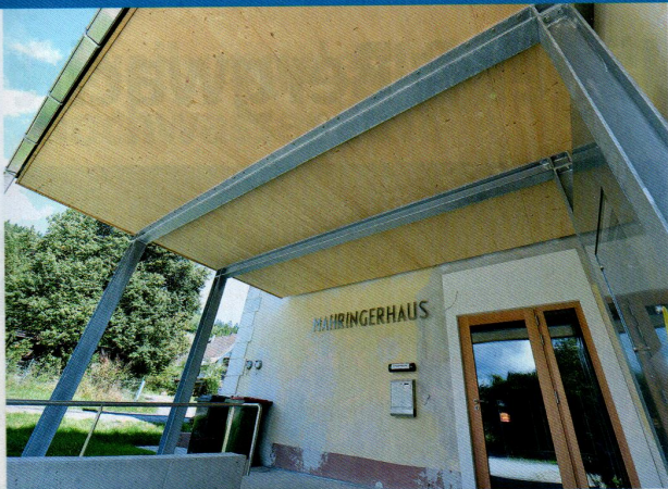
Neu: großzügige Überdachung des Haupteinganges
